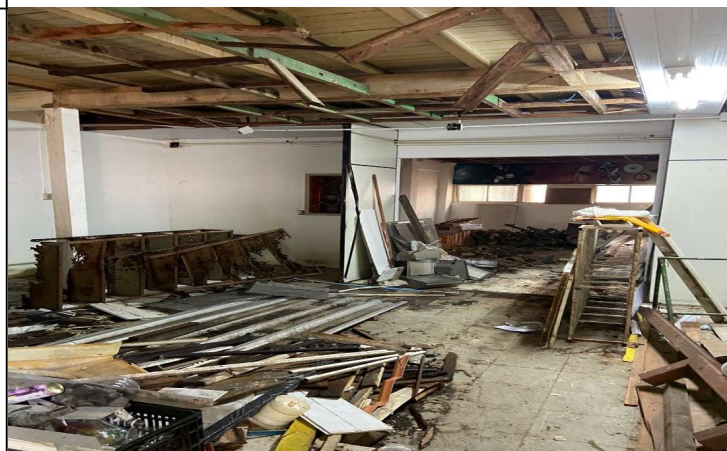
FOTO 12) APODRECIMENTO E ATAQUE BIOLÓGICO DAS ESTRUTURAS
