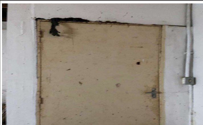
FOTO 3) ESQUADRIAS ESTUFADAS E C/ NECESSIDADE DE TROCA
