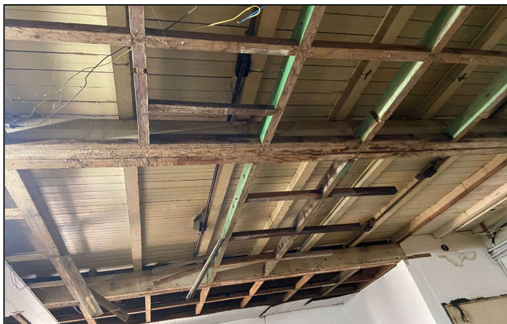
FOTO 7) ESTRUTURA EM MADEIRA DO PISO APRESENTANDO RISCOS
