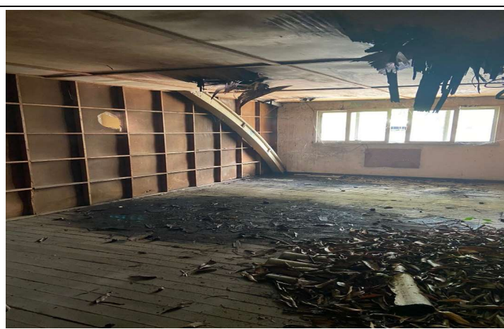
FOTO 2) FORROS, DIVISÓRIAS E PISOS C/ AVANÇOS DE DETERIORAÇÃO
