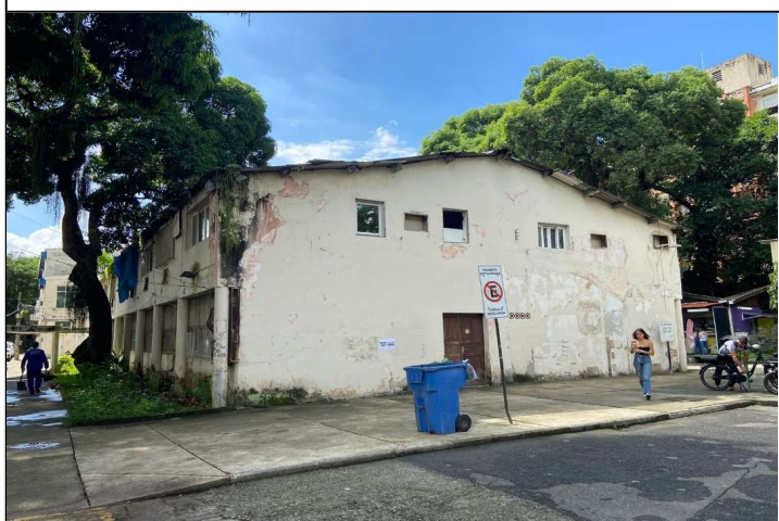
FOTO 9) PATOLOGIAS NA PINTURA E INFILTRAÇÕES NAS FACHADAS
