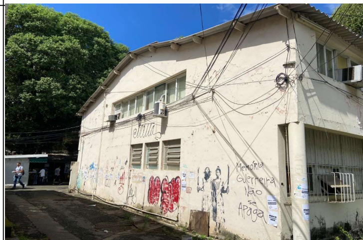
FOTO 10) INST.S ELÉTRICAS E DE DADOS SEM PADRÕES DE SEGURANÇA
