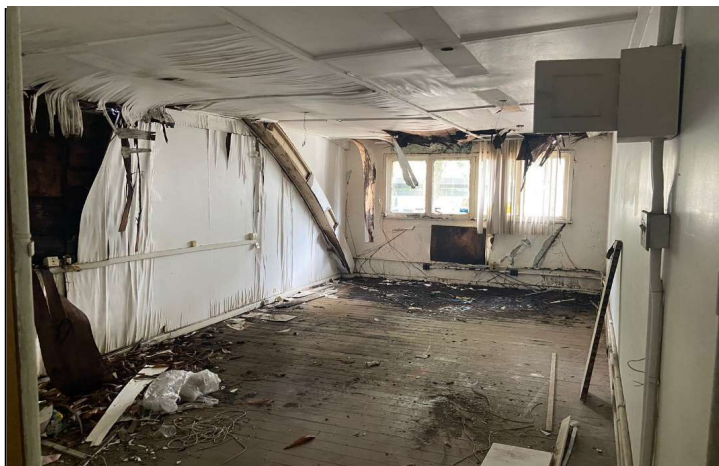
FOTO 1) VEDAÇÕES, ESQUADRIAS E INSTALAÇÕES DETERIORADAS
