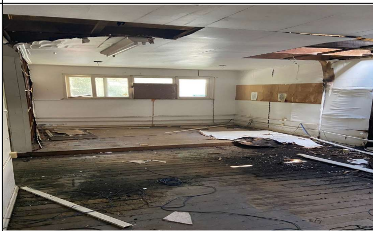
FOTO 6) FORRO COLAPSADO POR INFILTRAÇÕES FREQUENTES
