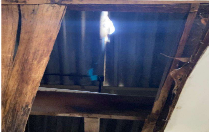
FOTO 8) TELHAS DANIFICADAS E ESTRUTURA DO FORRO COMPROMET.
